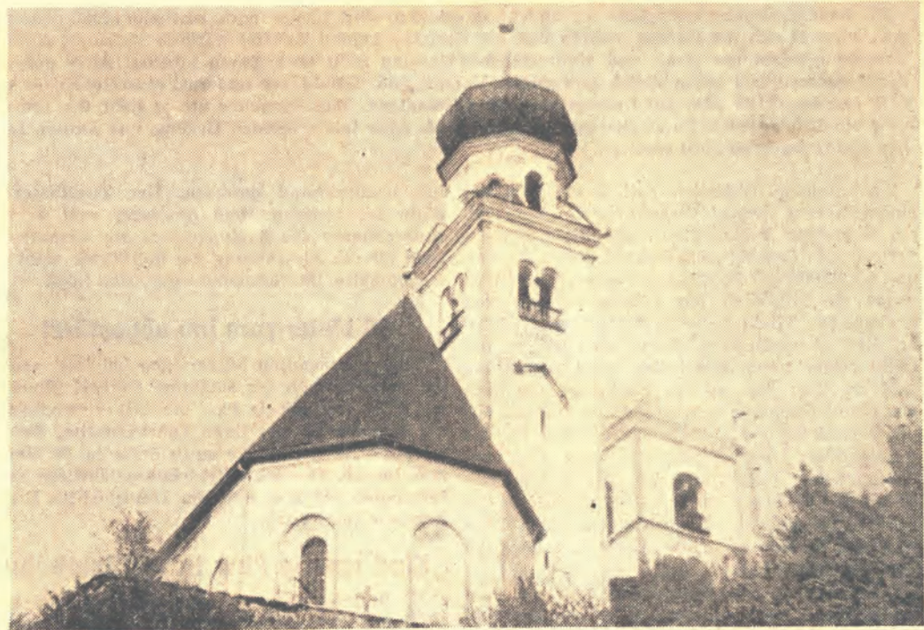
Die Feuerwehren konnten ein Ubergreifen des Brandes auf das Dach der Pfarrkirche verhindern. (Meir . .)
