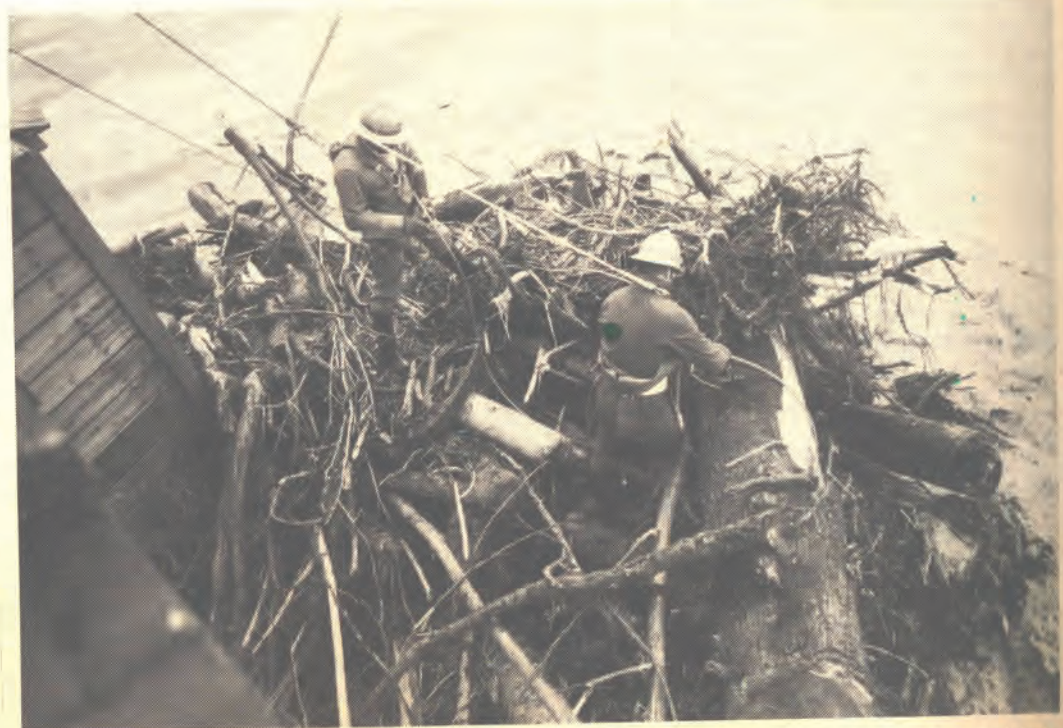
7. August: Angestaute Holzmassen drohen den Innsteg wegzureißen. Gruppenkommandant Sepp Steinlechner und HFM Peter Schwitzer bei ihrem „Himmelfahrtskommando“. Auf trügerisch schwankendem Standplatz schneiden sie den Weg für die tobenden Wassermassen frei.
