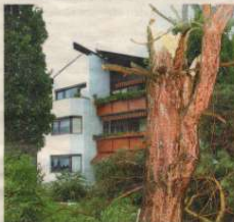
In Kirchbichl deckte der Sturm die Dächer von sieben Wohnhäusern ab. Foto: K. Ober
