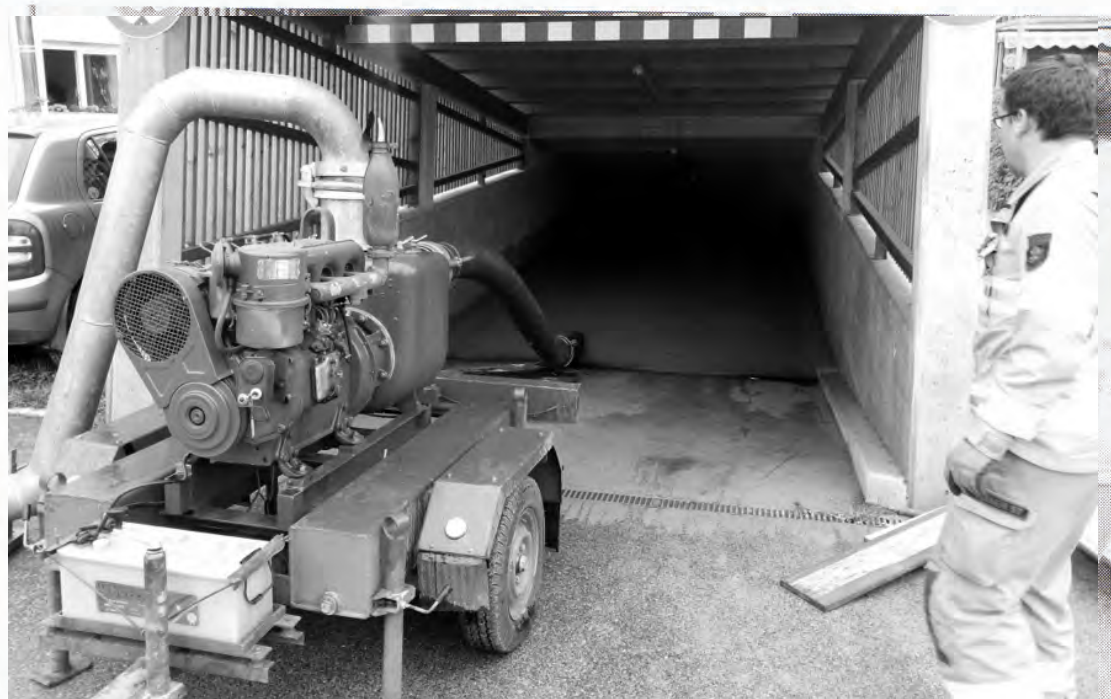
Beim Auspumpen einer Tiefgarage in Kössen
