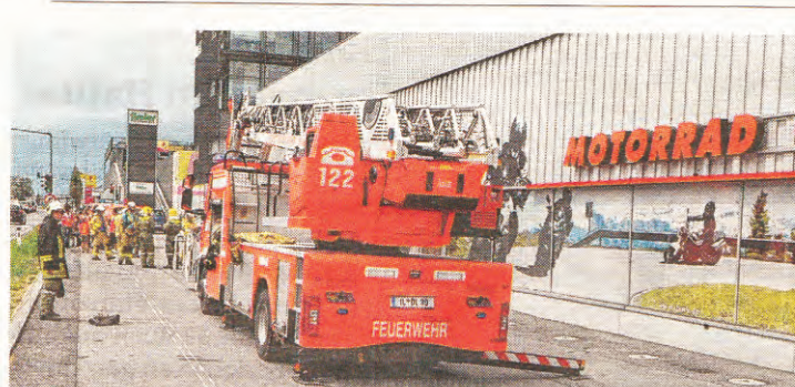
Für rund eine Stunde wurde ein Haller Geschäft gesperrt, dann gab ein Statiker das Gebäude wieder frei. Fotos: ZOOM-Tirol
