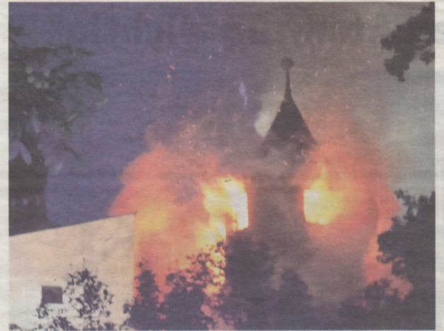
Komplizierter Einsatz in der Haller Altstadt: ein Dachstuhl fing Feuer.
