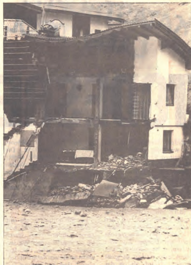
Ein Haus in Aschbach brach in sich zusammen und versank
