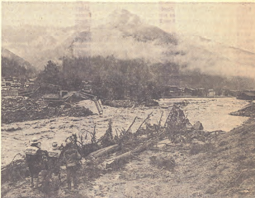
DAMMBRUCH IM STUBAI bei Milders, Gemeinde Neustift: Mit gefälltten Bäumen versuchte man, die Ruetz wieder einigermaßen zu regulieren. TT-Foto: Zoller
