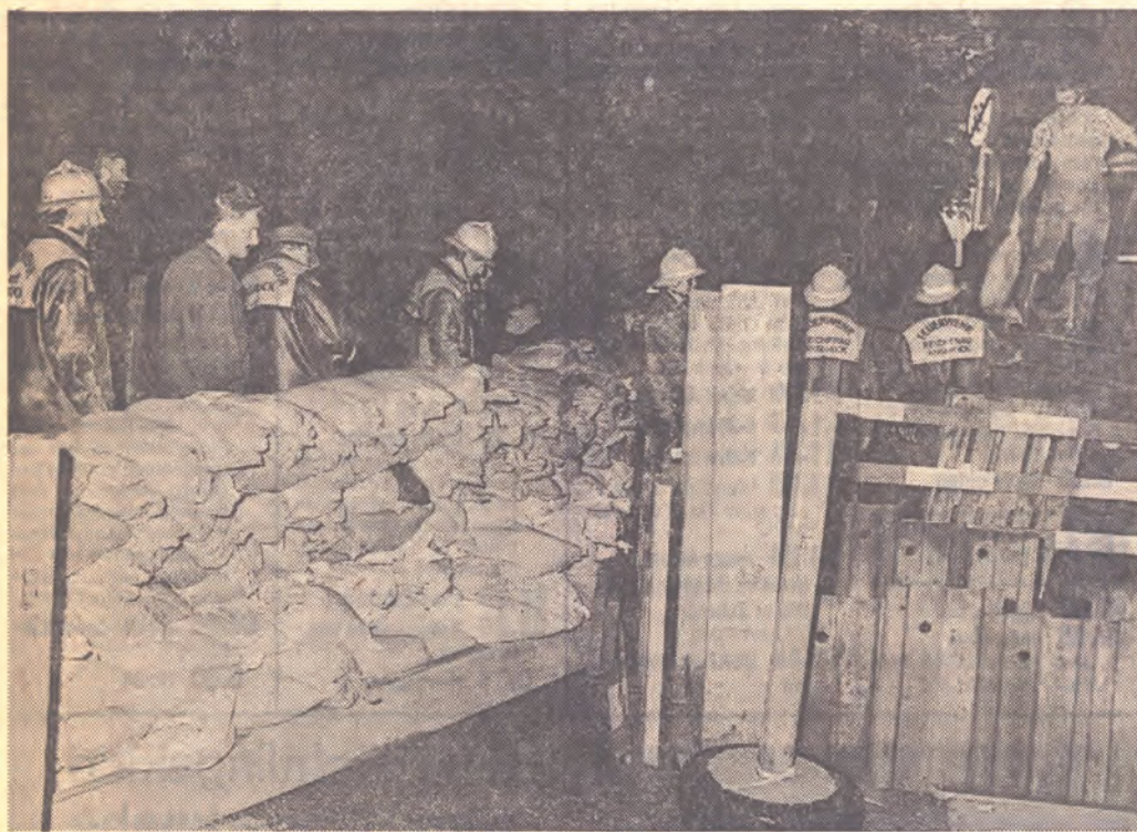
MIT 2000 SANDSÄCKEN versuchte die Innsbrucker Berufsfeuerwehr, die Sill einzudämmen. Diese trat lediglich bei der Rhombervilla über die Ufer. TT-Foto: Zoller
