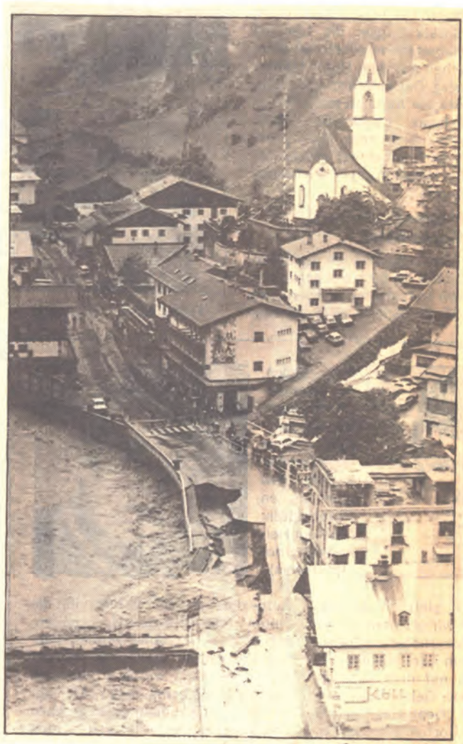
Wie von Zyklopenhand weg-gemeißelt: die Öztaler Bundesstraße im Ortskern von Sölden. In fünf Stunden vernichtete die Natur, was in jahrzehntelanger Menschenarbeit aufgebaut wurde
