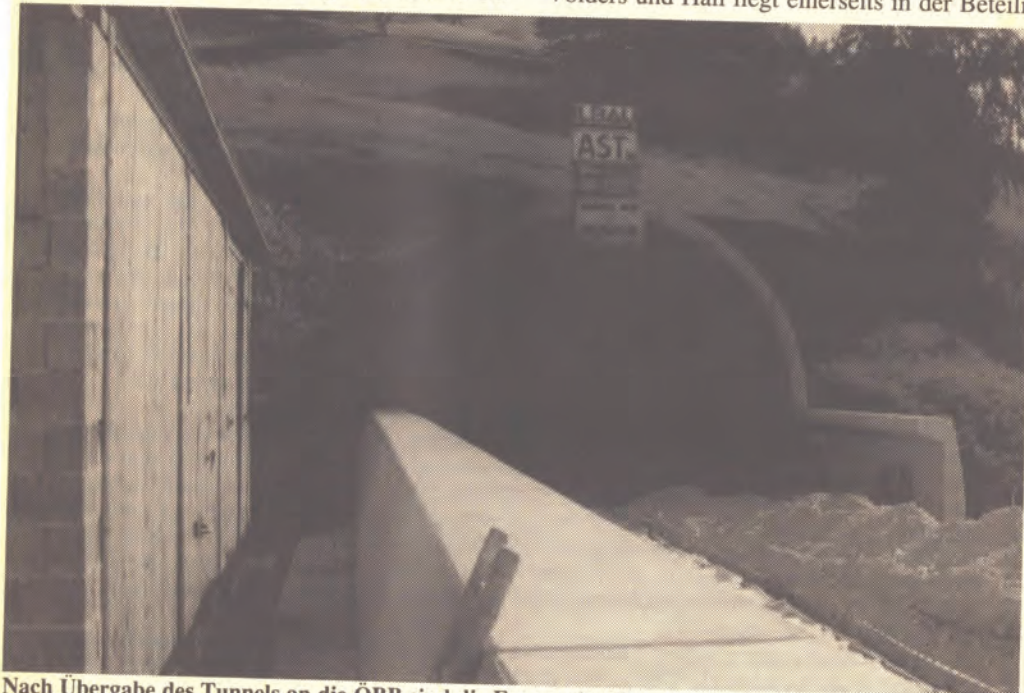
Nach Übergabe des Tunnels an die ÖBB sind die Feuerwehr Hall, Volders und Tulfes für die Überwachung des Nordportals verantwortlich.
